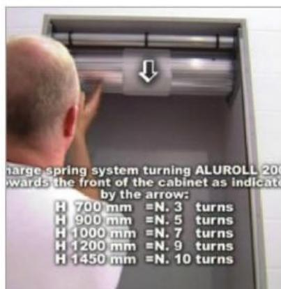
12. Отрегулировать усилие барабанного механизма путем вращения барабана в сторону опускания шторок-жалюзи. Количество оборотов зависит от высоты корпуса. Смотрите рисунок.
