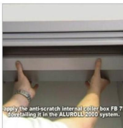
34. Установить между боковинами барабанного механизма крышку-заглушку, входящую в комплект модуля ALUROLL 2000.
