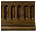
Накладка на подкарнизник
